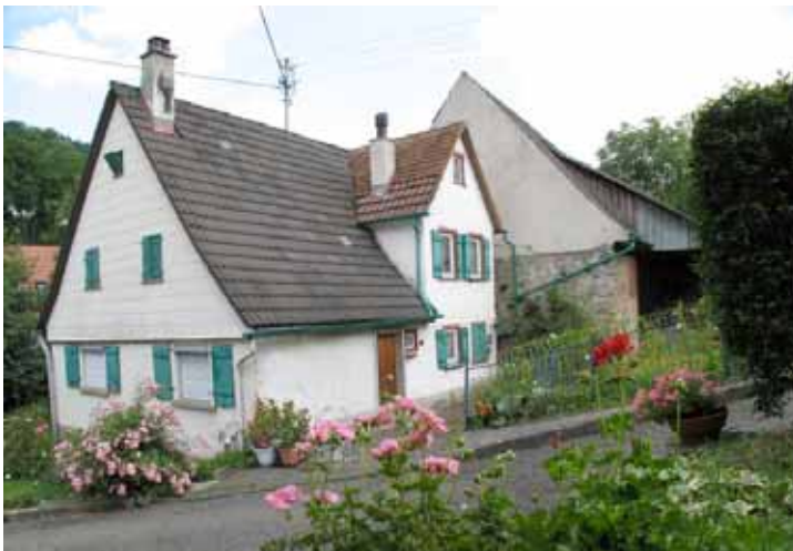
Bild 7: Gebäude Suhlburger Straße 69
